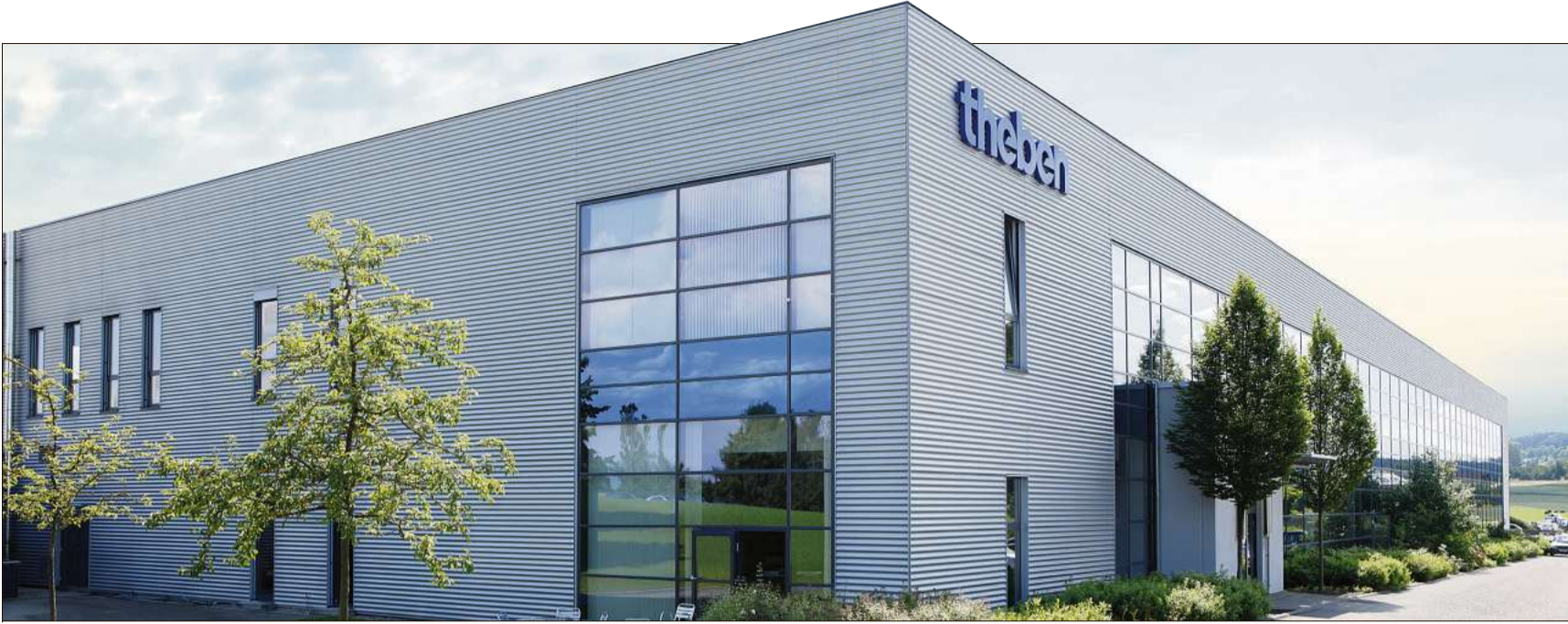
Theben (im Bild das neue, 5000 Quadratmeter große Produktionsgebäude im Gewerbegebiet Madertal) ist heute der größte Arbeitgeber in Haigerloch. Foto: Theben AG
